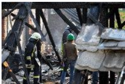
Die Löscharbeiten der Feuerwehr dauerten bis Donnerstagmorgen. (FOTO: PETER LISKER)
